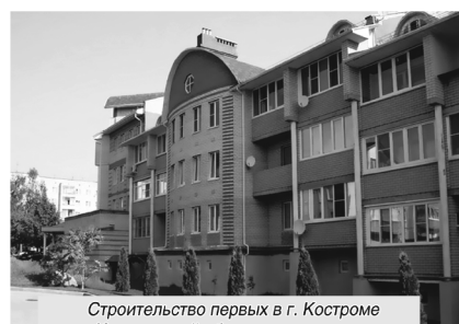
Строительство первых в г. Костроме и Костромской области многоквартирных жилых домов с индивидуальным отоплением.
